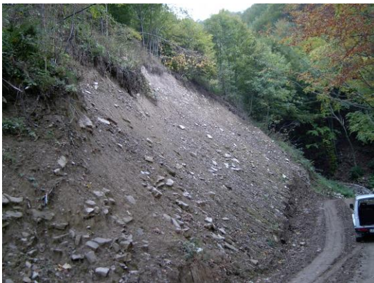
Strada classe C3 - scarpata naturale da consolidare con opere di I.N. (palificate doppie e grate vive)
