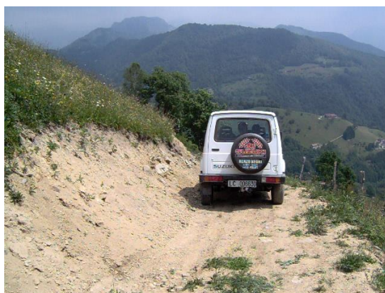
Pista C4 - transito di piccoli automezzi
