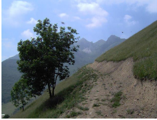
Strada classe C4 - interventi di inerbimenti sulla scarpata di monte
